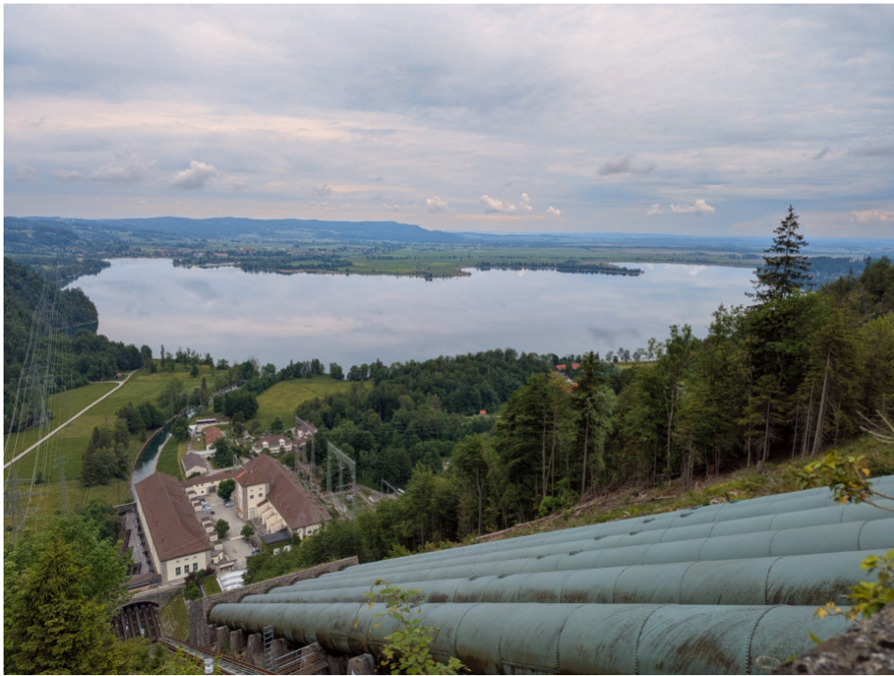
Das Walchenseekraftwerk nutzt seit seiner Inbetriebnahme 1924 den natürlichen Höhenunterschied von rund 200 Metern zwischen dem Walchensee und dem Kochelsee zur Stromerzeugung und gilt als eines der größten Hochdruck-Speicherkraftwerke Deutschlands.
